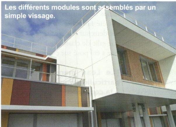
Les différents modules sont assemblés par un simple vissage.
